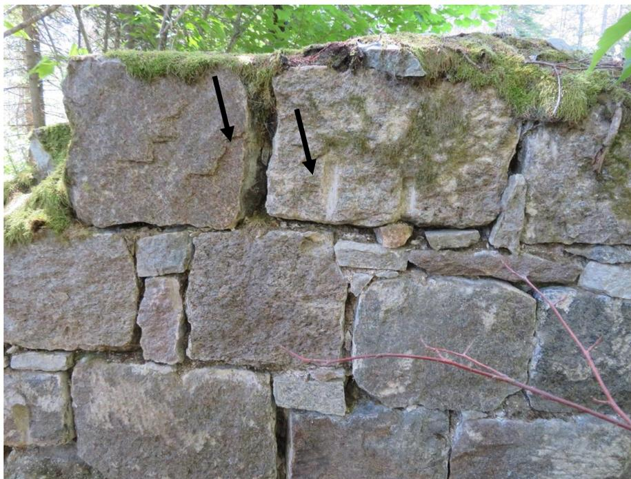
**Photo 20.** CjEp-3, vue du mur nord, avec traces de barre à mine, vue vers le sud
